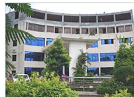
Больница, которой мы заведем в Дакке (до реконструкции)
