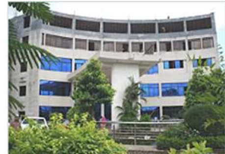
Больница, которой мы заведует в Дакке (до реконструкции)
